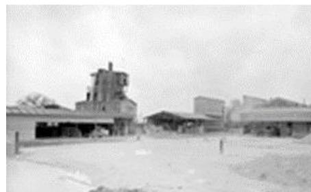
Le site industriel est desservi par un embranchement ferroviaire. Le four est à cinq niveaux, les deux premiers sont en pan de fer rempli de brique, le 3e est en tôle ondulée, le 4e en pan de bois et le 5e en matériau synthétique et couvert de ciment amiante. Plusieurs hangars récents sont en matière synthétique avec charpente métallique apparente couverte de ciment amiante.
