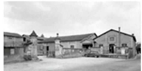
L'ancienne distillerie est en pierre de taille et couverte d'ardoise. La nouvelle distillerie est en moellon et couverte de tuile creuse, servant actuellement de garage. Les chais en rez-de-chaussée sont avec étage de comble et charpente en bois apparente, couverte de tuile creuse, ouvertures en arc segmentaire. Le logement patronal est à deux étages carrés et élévation à travées, en pierre de taille et toit avec croupe, couvert d'ardoise.
