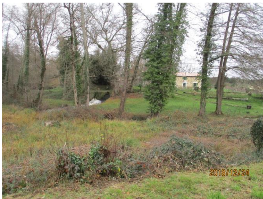
Exemple de moulin à Guizengeard où le classement selon l'article L151-19 permet de donner des prescriptions sur le bâti, sur les ouvrages hydrauliques bâtis, mais aussi sur la gestion de la végétation (maintien de parties naturelles ou non, conservation de certains sujets, possibilité d'en abattre d'autre, et mesures compensatoires pour la replantation)
