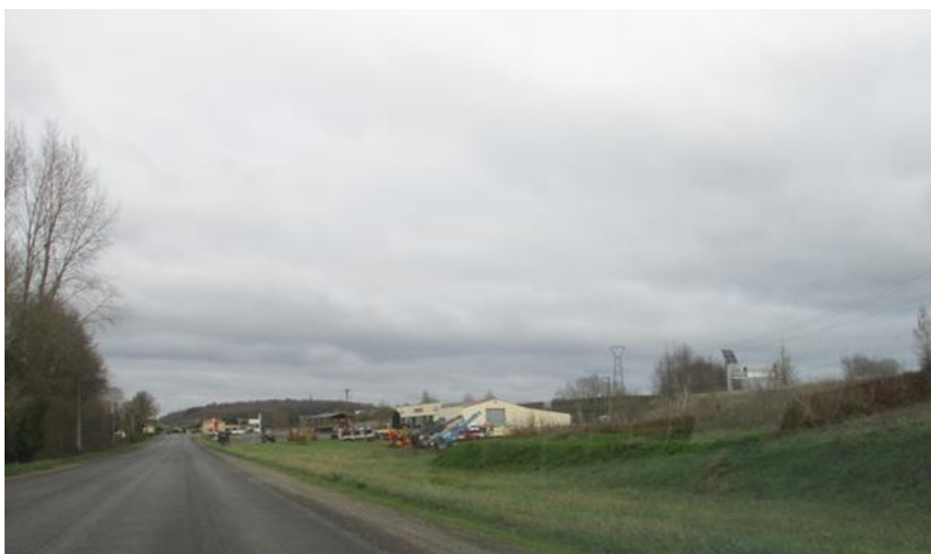
Développement linéaire d'activités le long de l'ancienne RN 10 : Reignac
